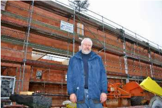
Uwe Rössel, Vorstandsvorsitzender vor dem Hallenrohbau
