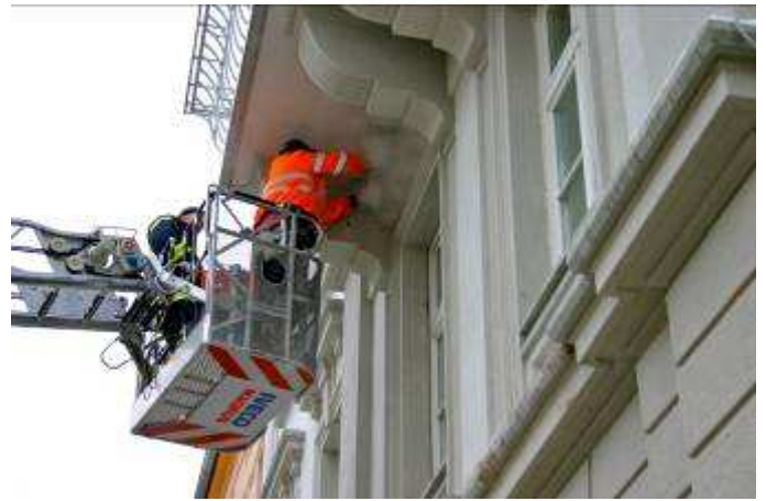
Vor Beginn der Ausschreibungen wurden alle betroffenen Gebäudebereiche, auch der Balkon, intensiv untersucht, um den Schadensumfang ermitteln und in Folge beheben zu können.
